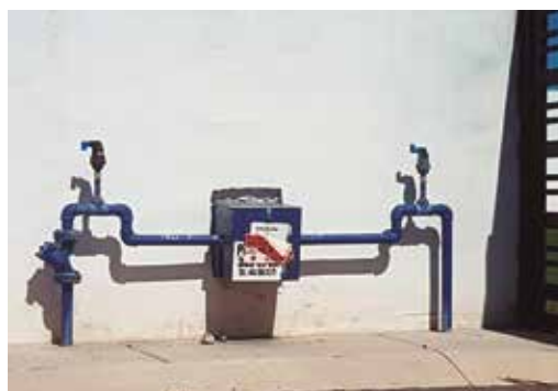
Macro-medidor de una cerrada de entre 60 y 100 viviendas en el conjunto estudiado en Querétaro, Querétaro
