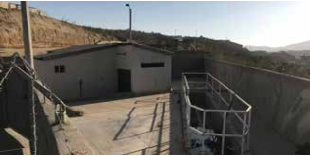
Cárcamo construido en conjunto por FIDUE y la empresa desarrolladora del conjunto estudiado en Ensenada, Baja California
