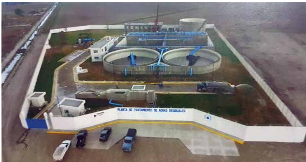
Primera etapa de la planta de tratamiento de aguas residuales en Tizayuca, en cuya planeación y construcción colaboró el desarrollador del conjunto estudiado
