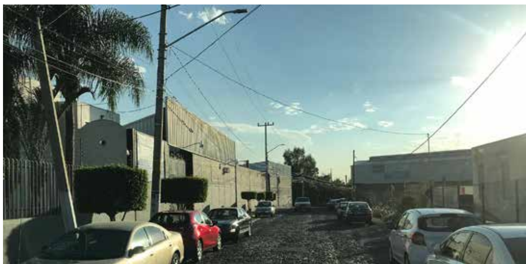
Vialidad que conecta al conjunto estudiado en Guadalajara, Jalisco con la estación del Macrobus , con empedrado, banquetas estrechas obstaculizadas por postes y árboles y con poca iluminación
