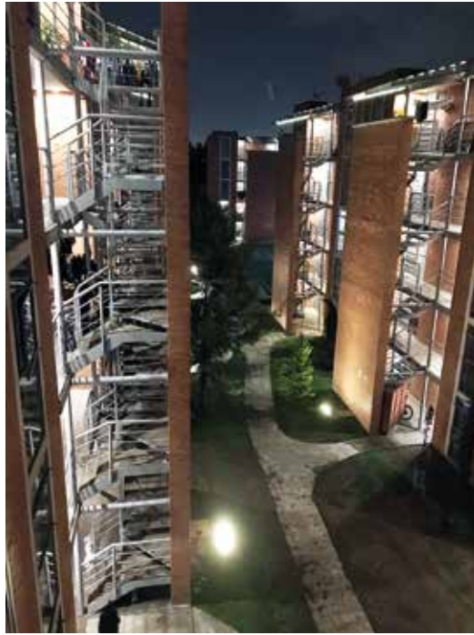
Iluminación nocturna de cubos de escaleras y pasillos de edificios del conjunto estudiado en Puebla, Puebla
