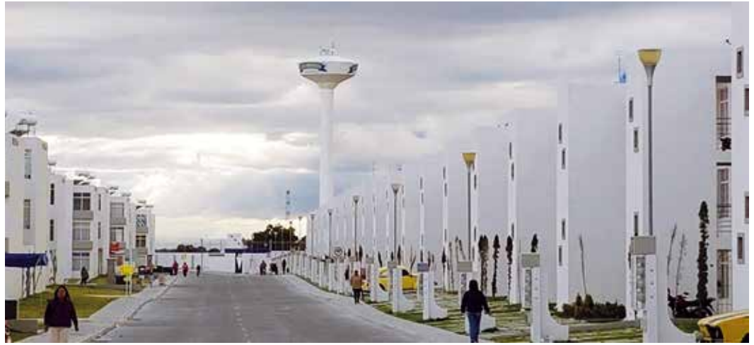
Uno de los dos tanques elevados de agua potable, que se alimentan de los pozos de extracción y abastecen al conjunto habitacional estudiado en Tizayuca, Hidalgo
