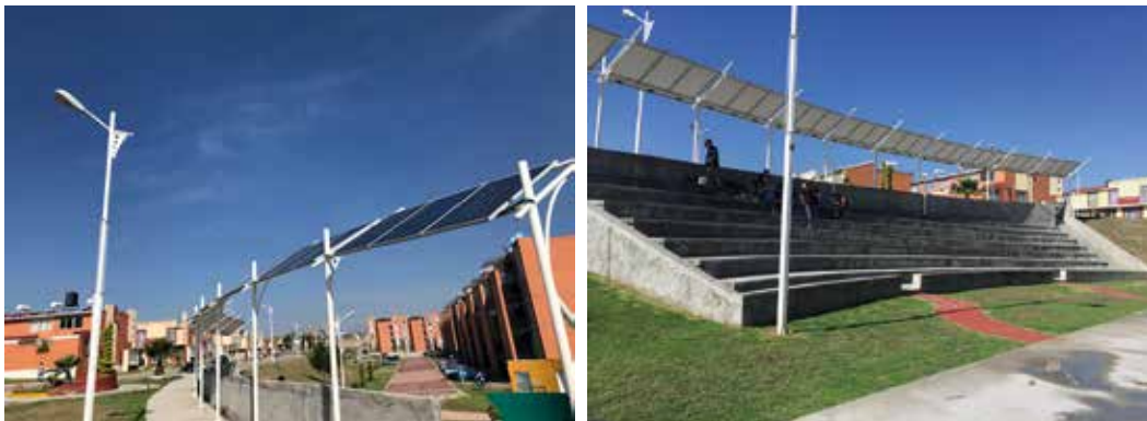
Estructuras con paneles solares colocadas de manera que proporcionan sombra al anfiteatro en el conjunto estudiado en Puebla, Puebla
