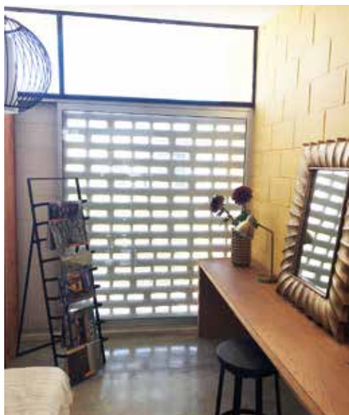
Ventanas remetidas y uso de celosías que permiten el paso de iluminación natural indirecta en vivienda modelo del conjunto estudiado en Hermosillo, Sonora
