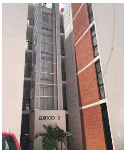
Elevador en edificio multifamiliar de cinco pisos en el conjunto de interés social estudiado en Mérida sur, Yucatán
