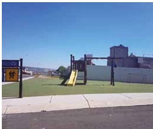
Juegos deteriorados en cerrada ubicada en una de las etapas más recientes del desarrollo, en el conjunto estudiado en Querétaro, Querétaro
