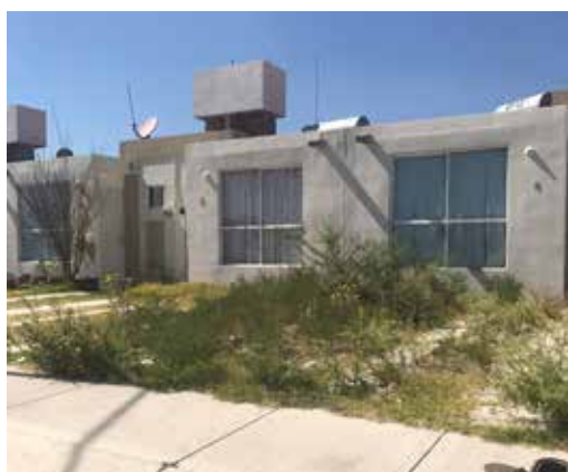
Patios frontales sin mantenimiento en cerrada con antigüedad de aproximadamente tres años, en el conjunto estudiado en Querétaro, Querétaro
