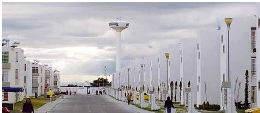
Tanque elevado de agua
