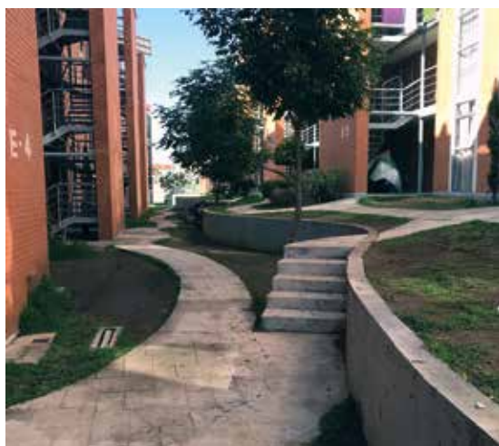
Andadores con áreas ajardinadas entre edificios de vivienda en Puebla, Puebla
