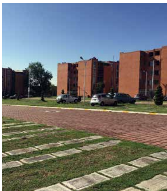
Áreas de estacionamientos con superficies permeables en el conjunto estudiado en Puebla, Puebla
