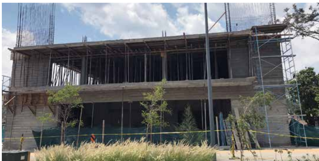
Área comercial en construcción
